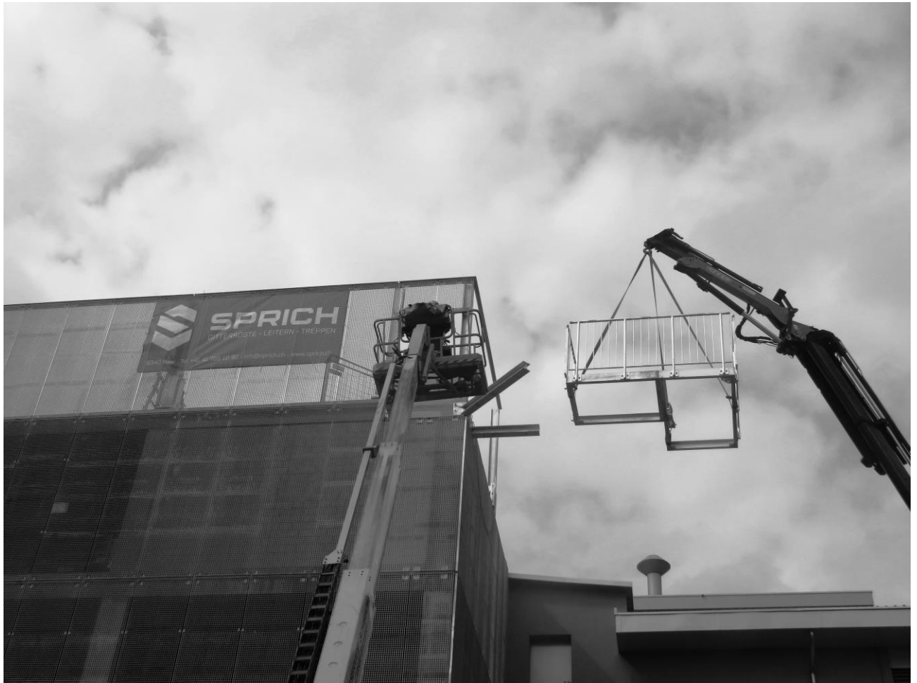
Bild: Montage einer Treppe
