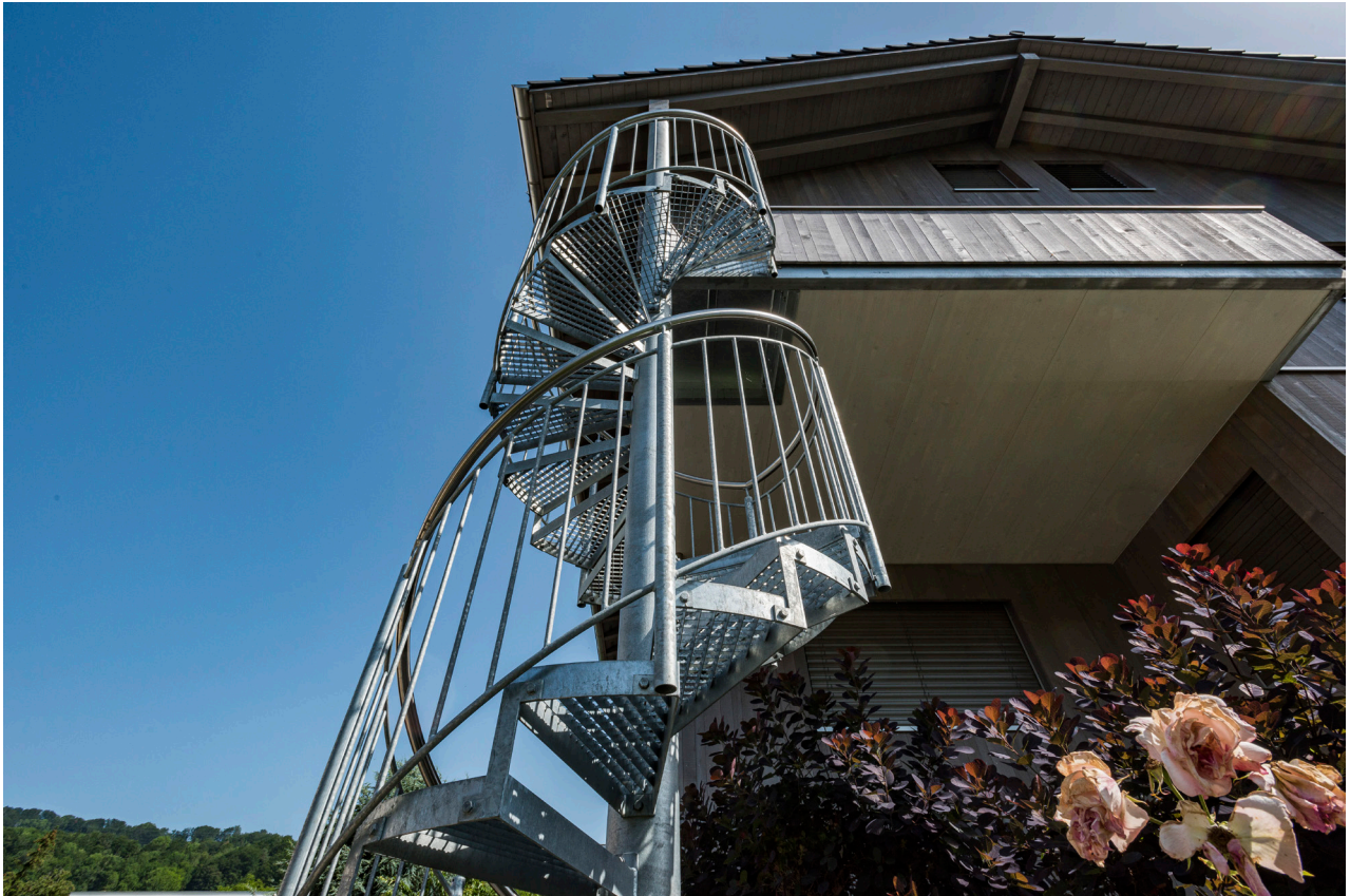
Spindeltreppe mit Staketengeländer und aufgesetztem Chromstahl Handlauf (in Halbschale verschraubt) und Geländertyp B.
