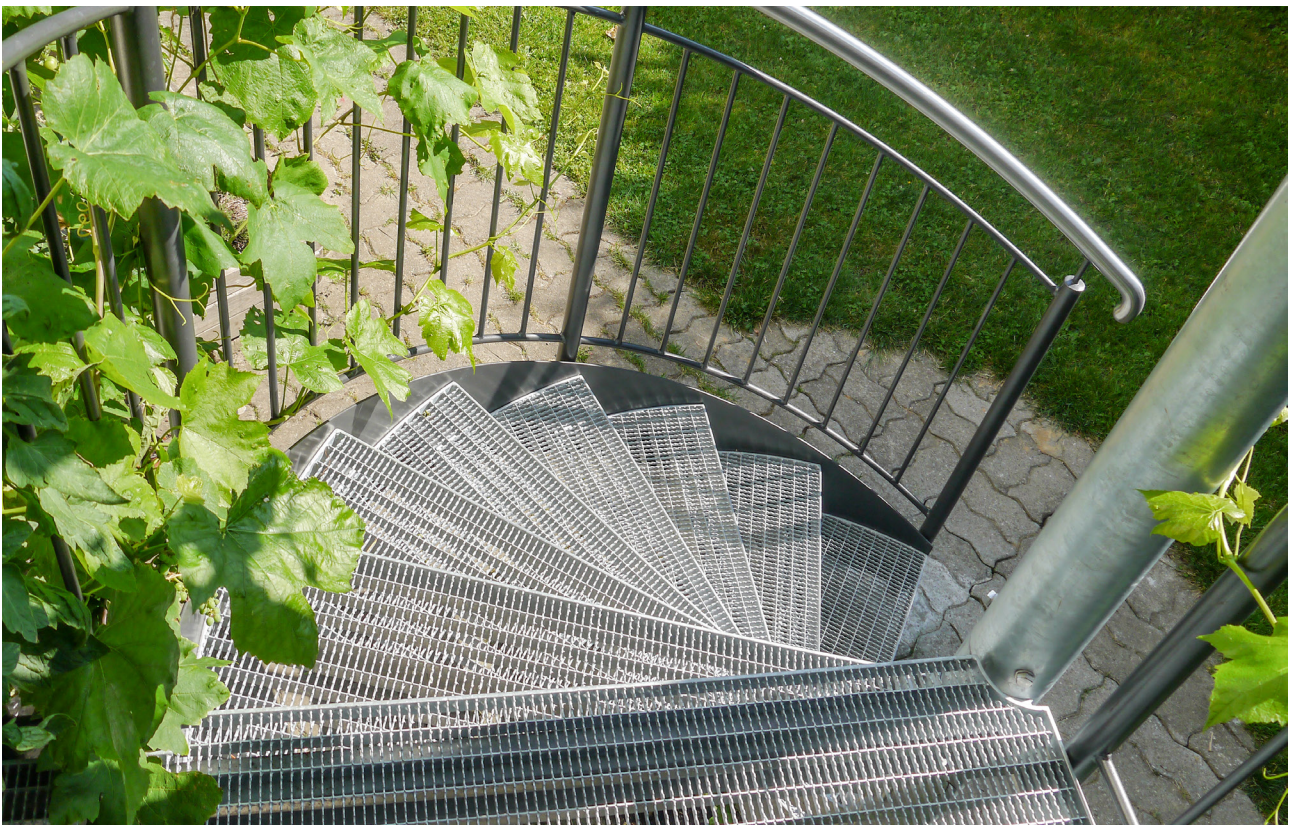
Spindeltreppenstufen Masschenweite 33x11 mm, einfacher Gleitschutz.
