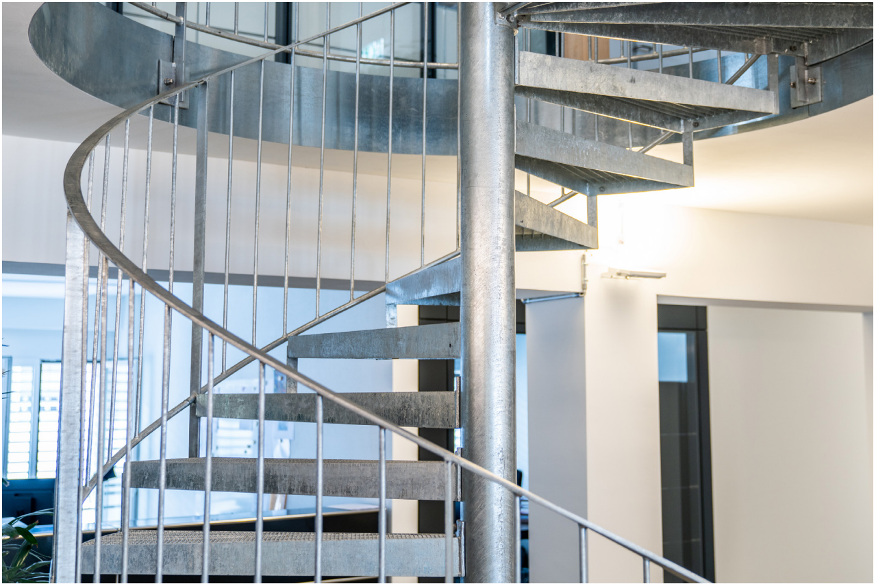
Spindeltreppe mit Flachstahl-Handlauf und Geländertyp A.
