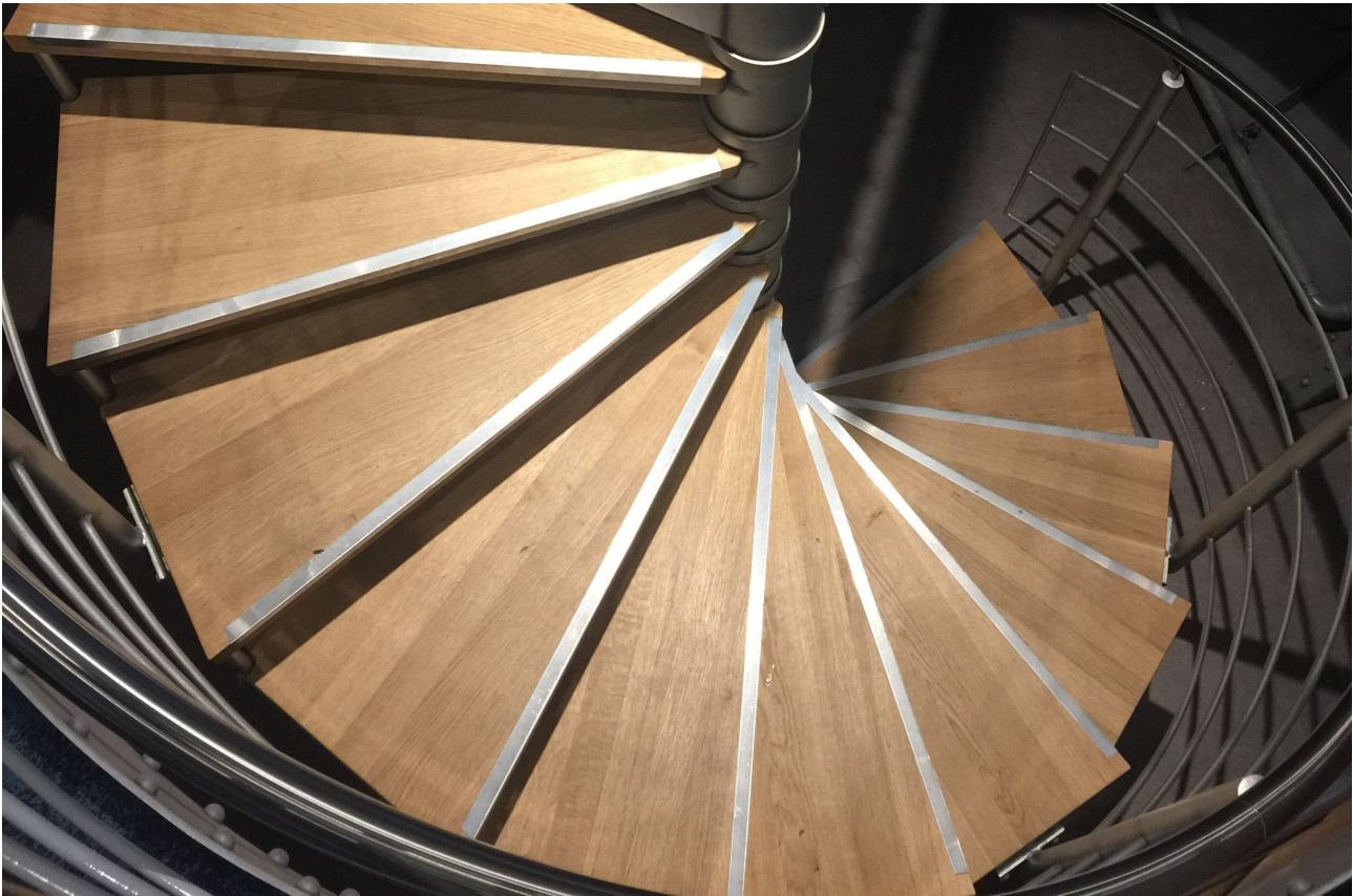
Spindeltreppenstufen mit Holzbelag.
