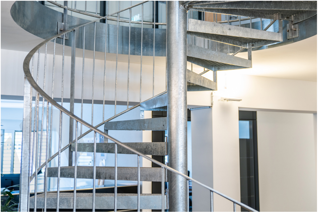
Spindeltreppe mit Flachstahl-Handlauf und Geländertyp A.
