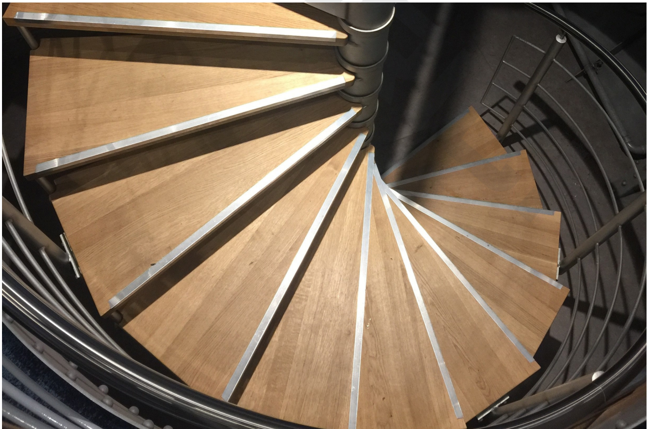
Spindeltreppenstufen mit Holzbelag.
