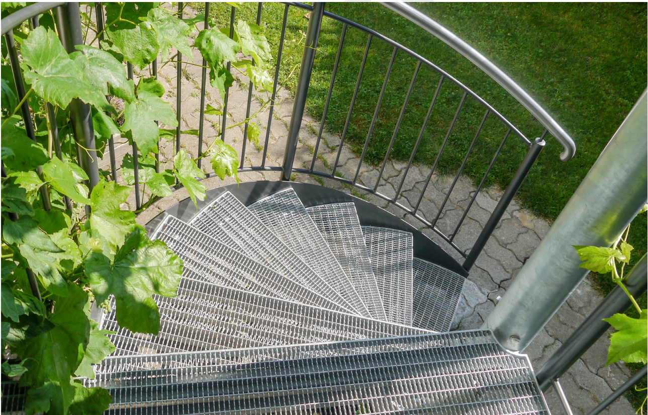
Spindeltreppenstufen Masschenweite 33x11 mm, einfacher Gleitschutz.
