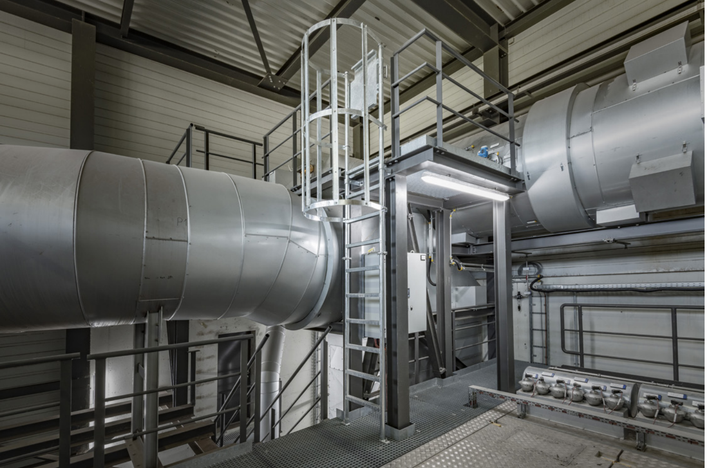
Steigleiter mit Rückenschutz und Ein-/Ausstiegstürchen. Échelle à crinoline avec portillon d'entrée/sortie.
