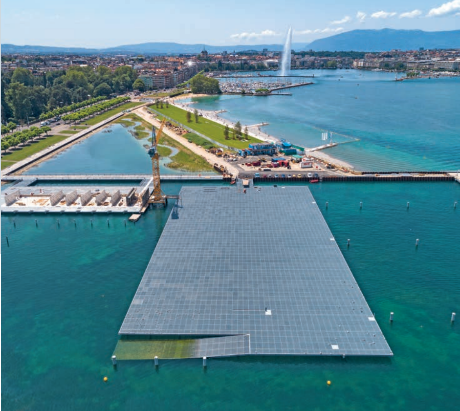
Bereits sind rund 9000 m 2 respektive 440 Tonnen Gitterroste geliefert und montiert worden. Environ 9000 m 2 , soit 40 tonnes, de grilles caillebotis ont déjà été livrées et montées.
