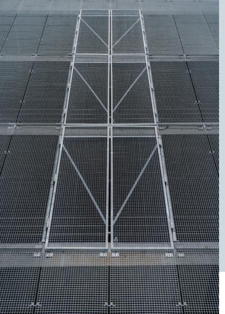
Über der Einfahrt sind drei riesige Doppelflügeltüren - komplett aus Gitterrosten - eingebaut. Sie ermöglichen die Einbringung von grossvolumigen Materialien. Au-dessus de l'entrée se trouvent trois portes à double battant, entièrement en grilles caillebotis. Elles permettent l'arrivée de matériaux très volumineux.
