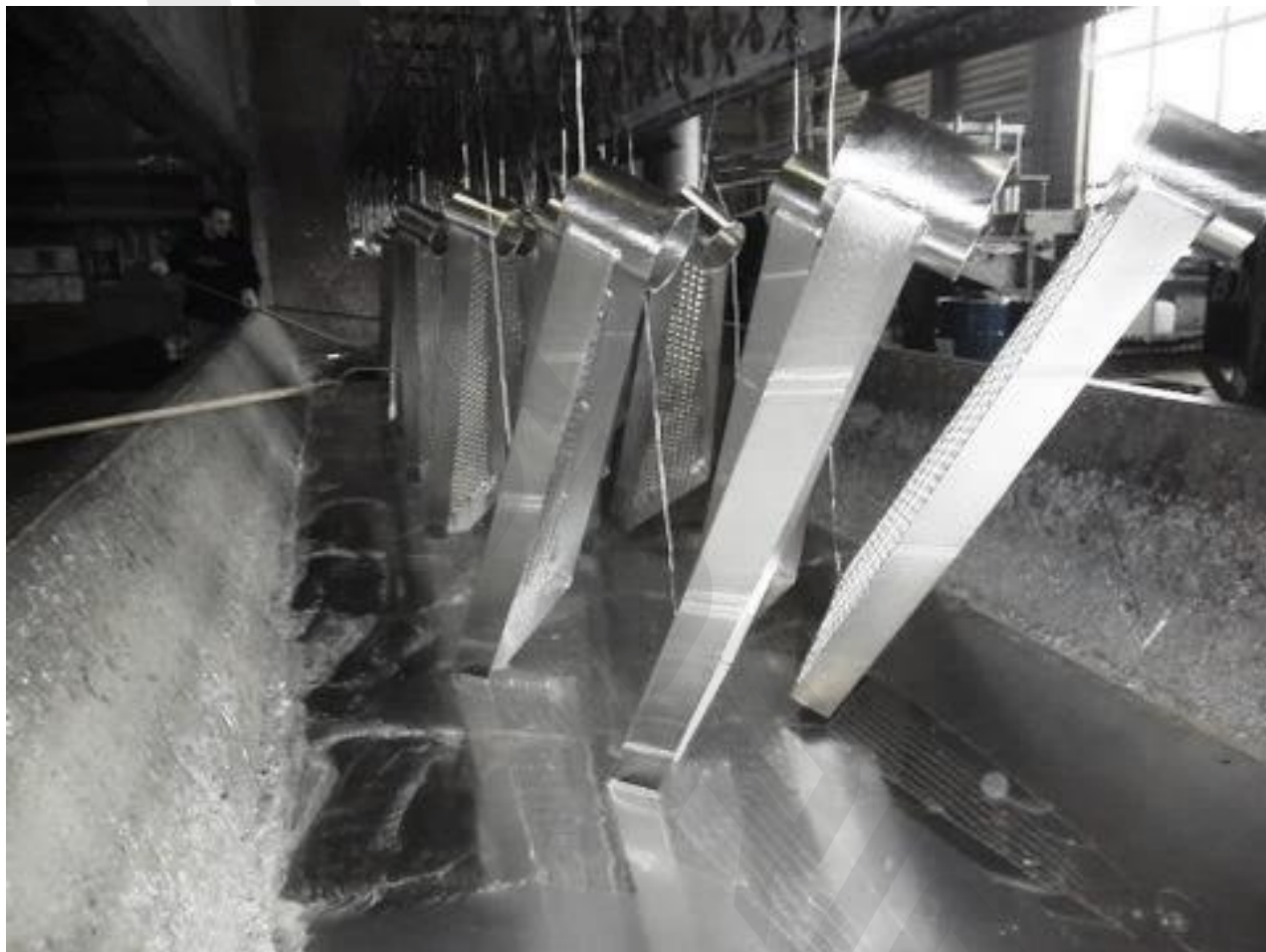
Illustration : galvanisation de marches d'escalier en colimaçon
