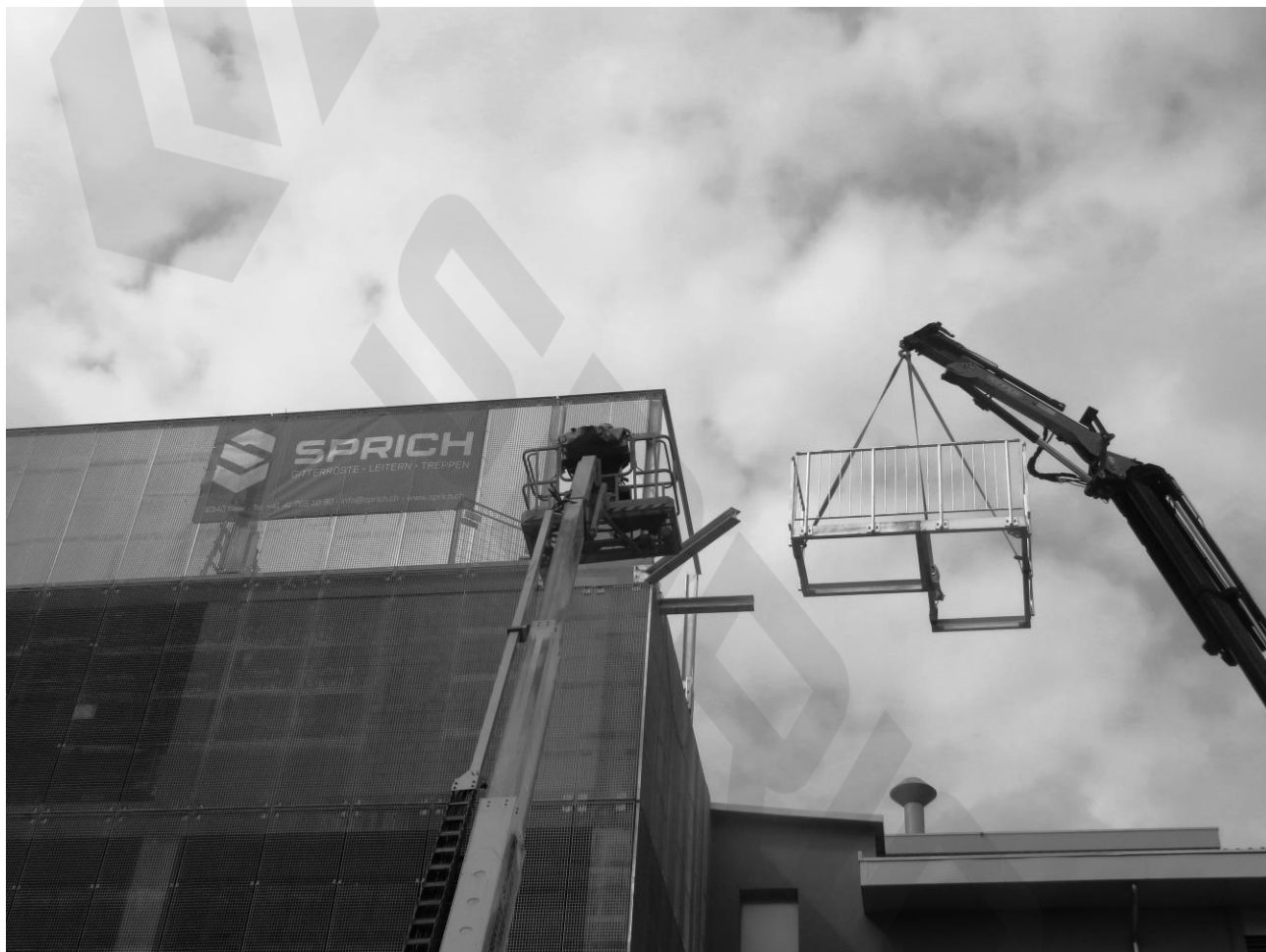
Illustration : montage d'un escalier
